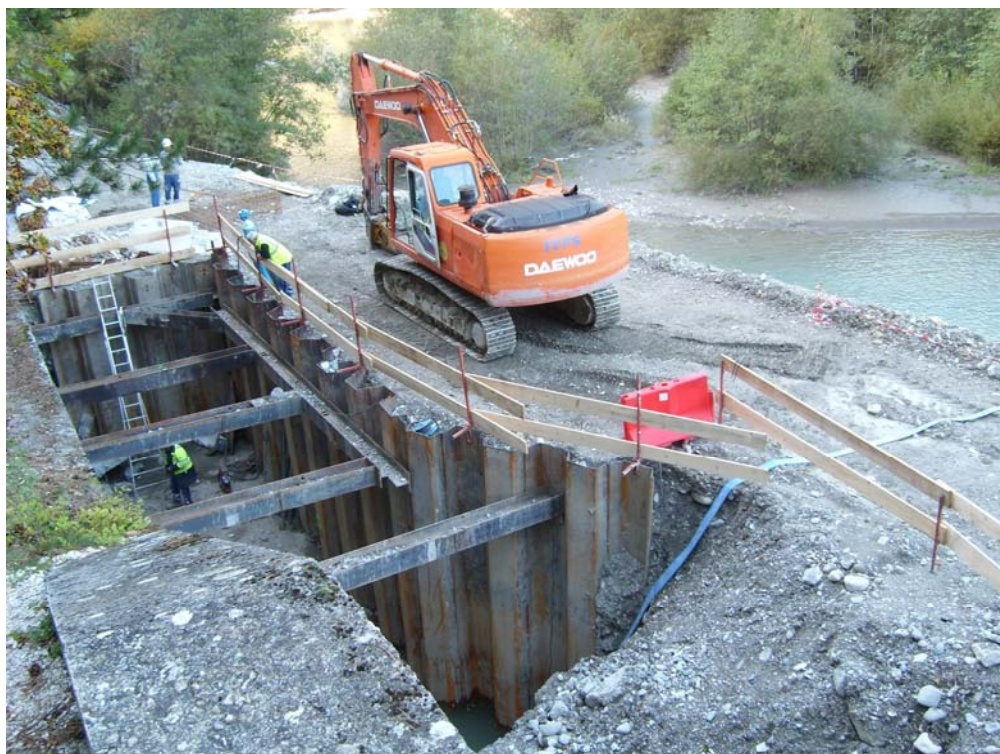
Construction d'une passe à poisson dans le seuil EDF de Chaudanne
